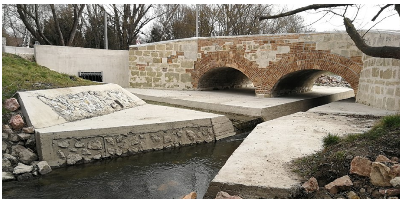
Váli közúti boltozott téglahíd felvízi medre a beavatkozás után
