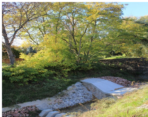
Vál, Burgondiái-árok vízmosás megkötés vízmosáskötő gátak építésével
