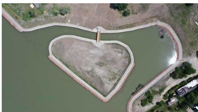
Brajnovits-öböl vízminőséget javító öblítő csatornával
