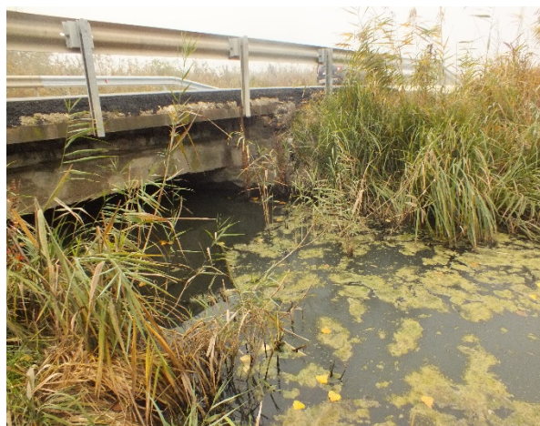
Bicske I. sz. halastó alatti mányi úti híd
