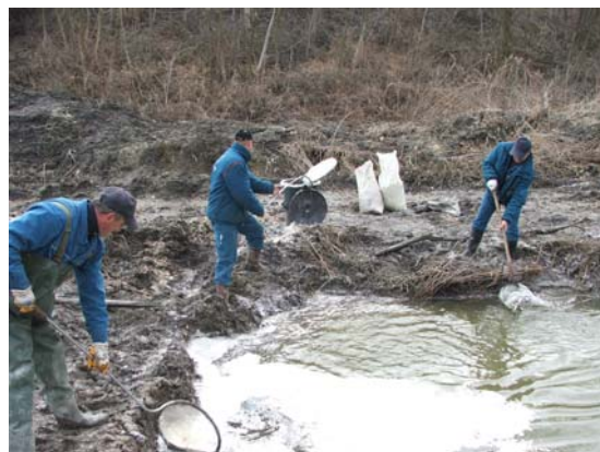
15-8. kép. Olajszennyezés eltávolítása perlitel
