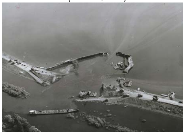
12–10. kép Az árvíz elmosta a vasúti töltést (Körösök, 1974)
