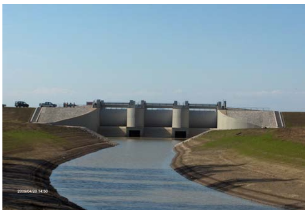
12–20. kép. A Cigánd-tiszakarádi árvízi tározó feltöltő műtárgya
