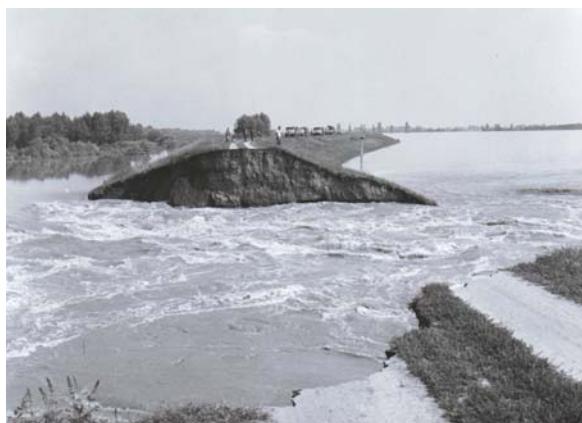
12–11. kép. Kettős-Körös jobb parti töltésszakadás Hosszúfoknál (1980)
