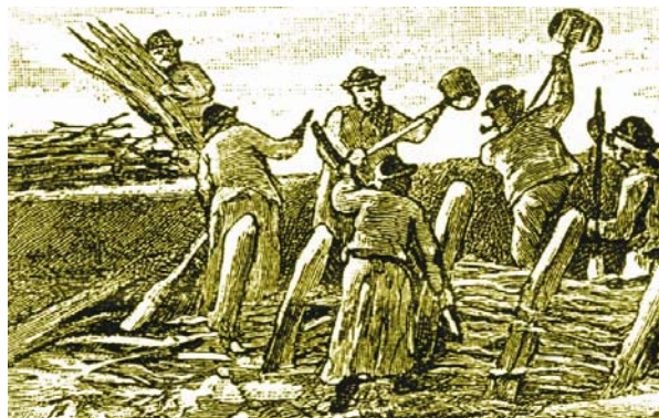
12–4. kép. Töltésoldal védelme hullámverés ellen a XIX. század végén
