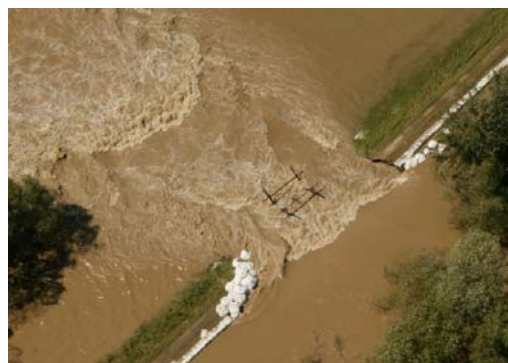
12-17. kép. Gesztelyi gátszakadás a Hernád jobb parton
