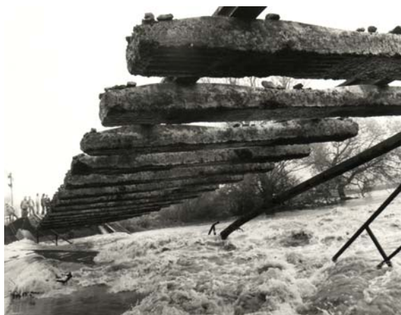
12–10. kép Az árvíz elmosta a vasúti töltést (Körösök, 1974)
